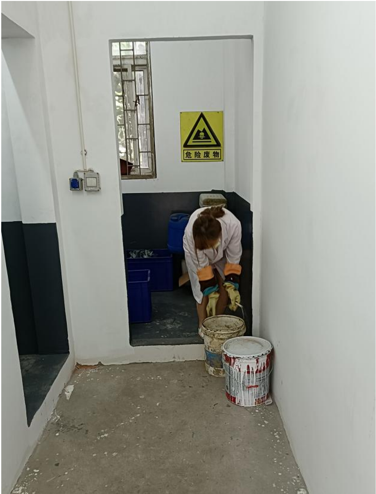
危废泄漏演练
